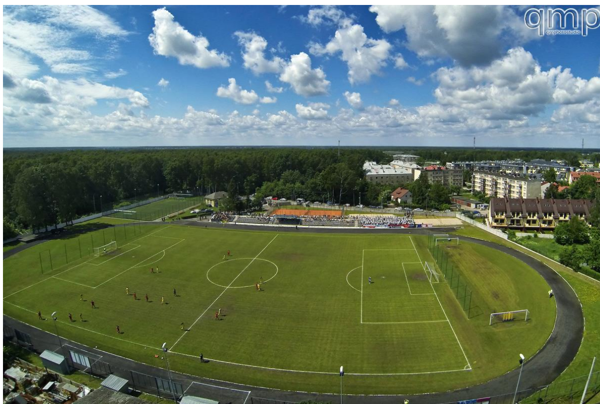
Zdjęcie 4. Stadion Miejski przy ul. Sportowej 1 w Mińsku Mazowieckim
